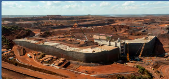
Obras no Complexo S11D (PA)
